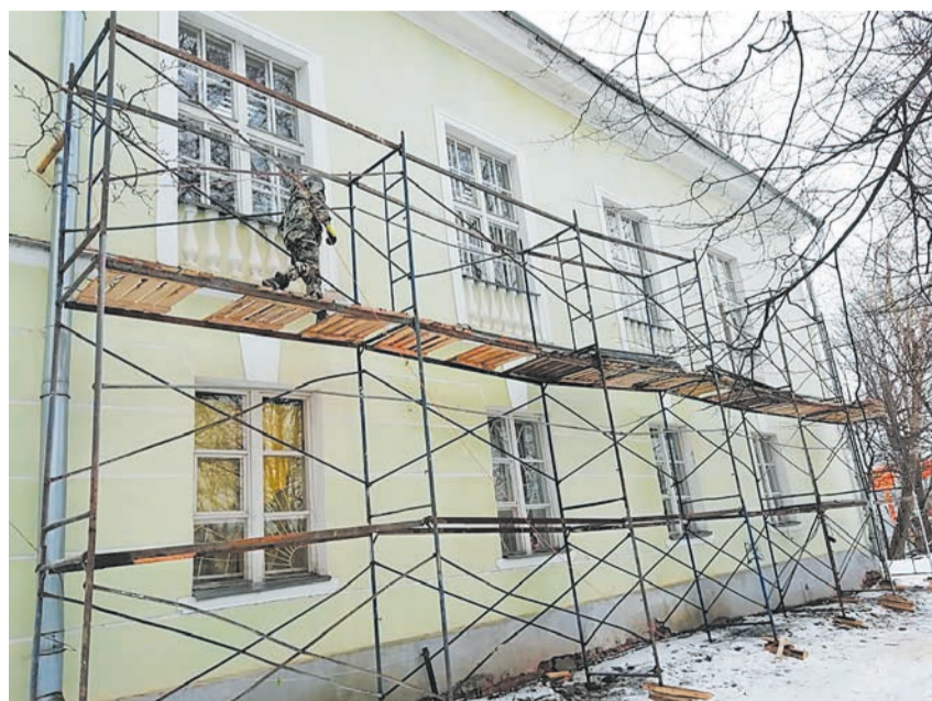
Подрядчик готовит фронт работ
